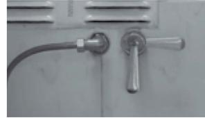
Cierre el gas del termostato a través de la perilla robinete de pasaje de gas o de la llave de paso antes de drenar el agua del artefacto.
