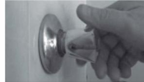
Para vaciar la unidad cierre la válvula de la línea de suministro del agua fría. Luego abra la canilla de agua caliente para permitir la entrada del aire al tanque. Conecte una manguera al grifo de purga y dirija el chorro de agua hacia cualquier zona que no pueda ser dañada.
